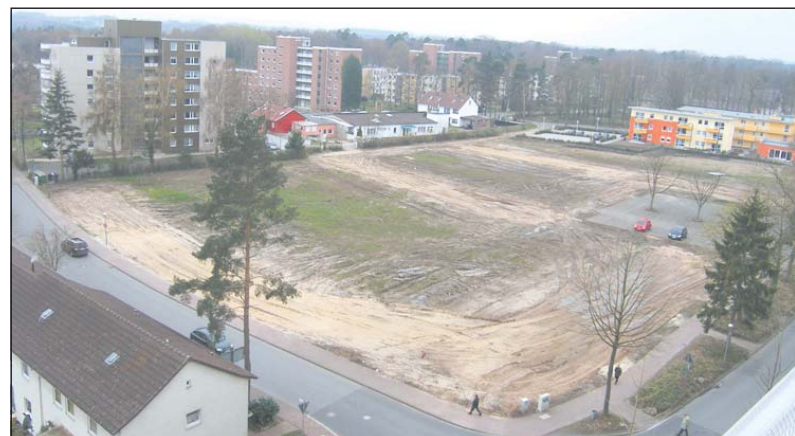
Auf diesem etwa 15 000 Quadratmeter großen Areal sollen unter anderem zwei Gebäude mit Eigentumswohnungen entstehen.
