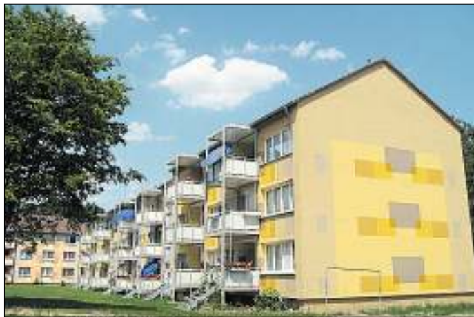
Neu gestaltete Fassade, Balkone und Eingangsbereiche beim Mietobjekt Stolper Weg in Espelkamp. Fotos: privat
