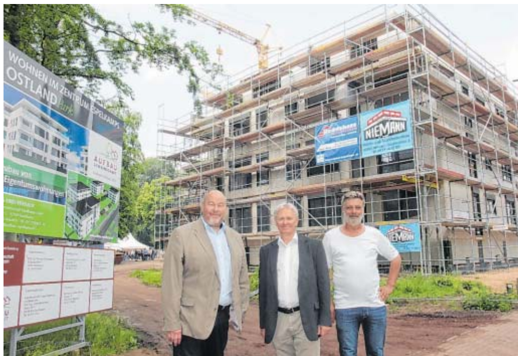
Alles in einer Hand: Der Geschäftsführer der Aufbaugemeinschaft Hans-Jörg Schmidt mit Architekt Andreas Durczok und Bauleiter Uwe Stark.
