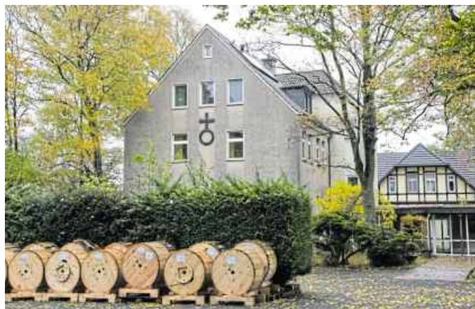
Hier wurde oft an- und umgebaut: Zuletzt nutzte die Firma Greenfiber, die in Pr. Oldendorf das Glasfasernetz ausbaut, den Pollertshof. Archivfoto: Cornelia Müller
