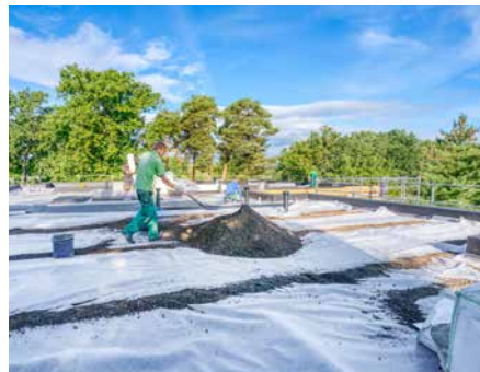
Lebensraum in luftiger Höhe: Das Flachdach in der Birger-Forell-Straße wurde vollständig erneuert und mit einer artenreichen, extensiven Dachbegrünung versehen.
